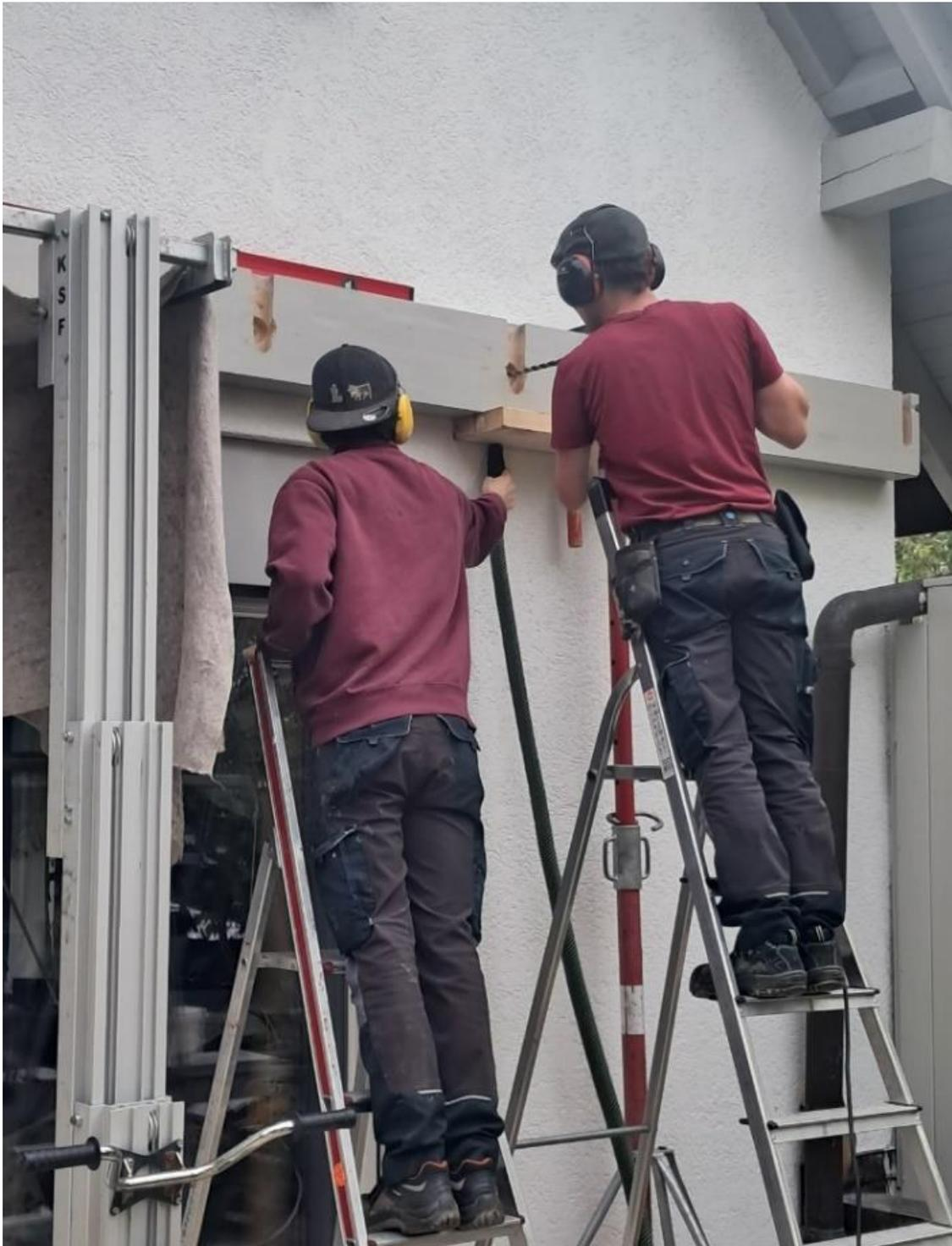
Abbildung 6: Schreinermeister und Mitarbeiter beim Montieren eines Solarcarports
