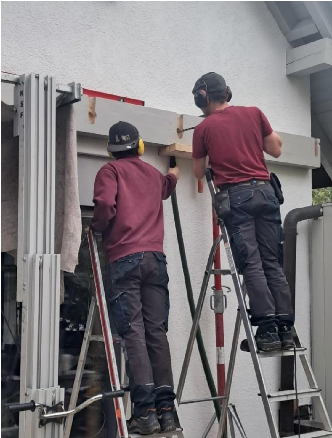
Abbildung 6: Schreinermeister und Mitarbeiter beim Montieren eines Solarcarports
